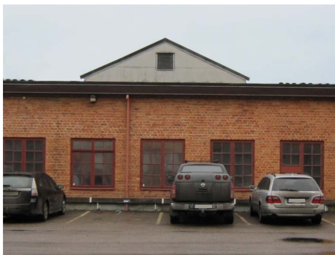
Fd industribyggnadens värdefulla utseende på fönster och tak längsmed långsidan mot Köpmangatan
